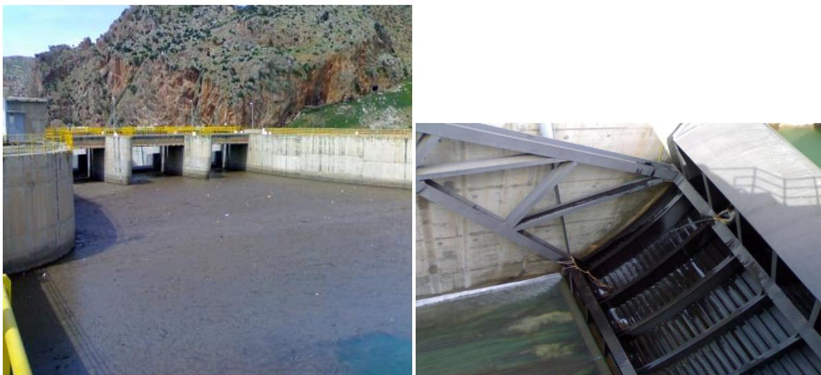
Vannes segment au barrage Allal Fassi
