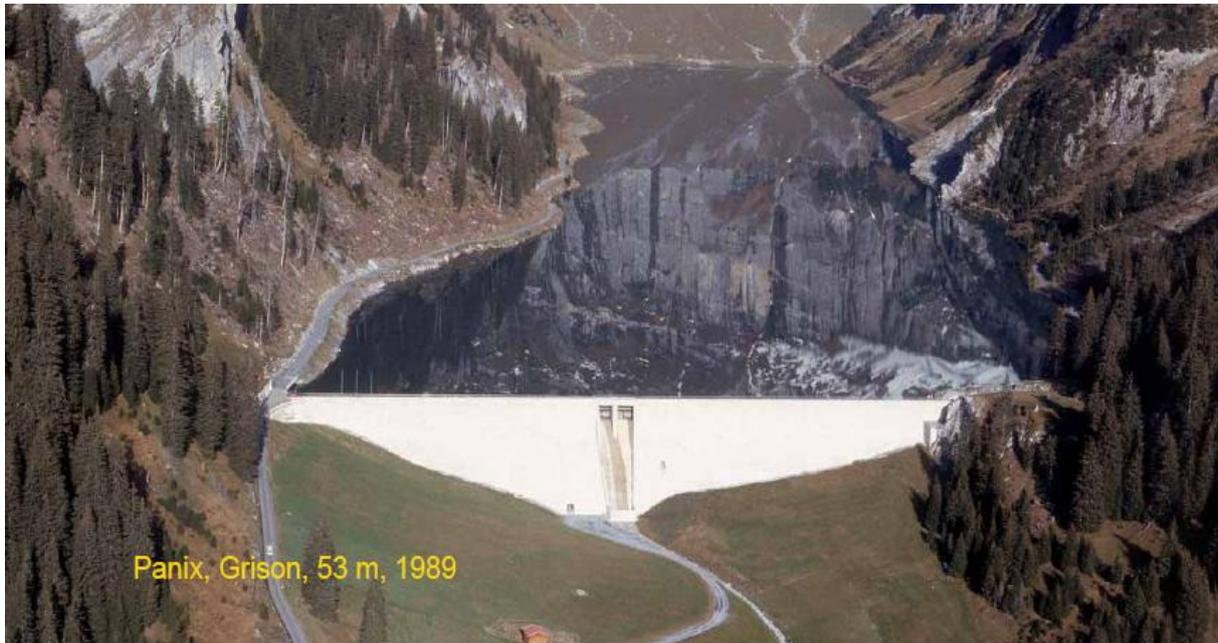
Ils ont une section triangulaire ou trapézoïdale. Leur poids propre suffit pour contenir et résister à la poussée de l'eau.
