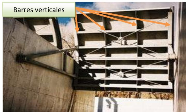
La force appliquée par l'eau peut être répartie soit d'une façon triangulaire soit trapézoïdale et ceci en fonction de la fonction de la vanne :
