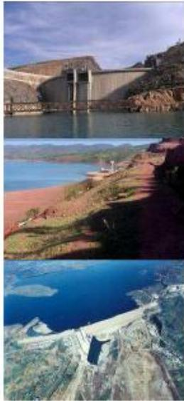
Barrage Asfalou : Barrages Voûte d'une longueur de 150 m et une hauteur de 110 m
