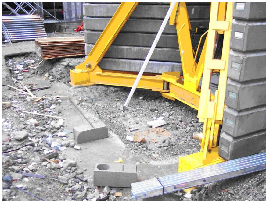
Dalle de la grue
