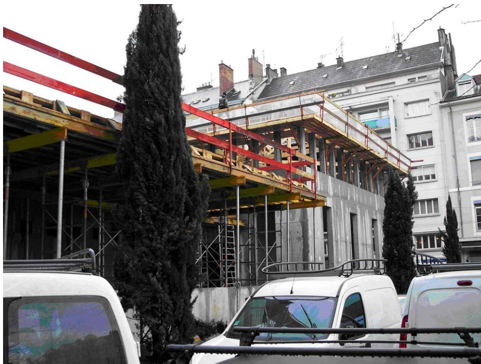
Coffrage de la dalle au dessus des sanitaires
