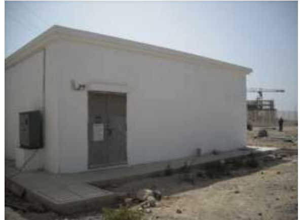
Poste Répartiteur Général N°1
