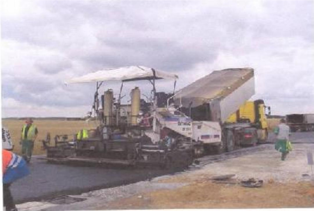
Immédiatement après le réglage avant le cylindrage, la surface sera vérifiée pour corriger les irrégularités, enlever les impuretés ou accumulation de matériaux mal enrobés et les remplacer par un matériaux satisfaisant. Et sera après compacté à l'aide d'un compacteur vibrant, et autre à pneu.
