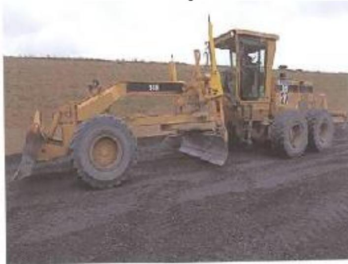
Pendant son répandage, le tout-venant sera arrosé de telle sorte que sa teneur en eau soit portée à une valeur supérieure de deux points à celle correspondant à l'optimum de l'essai POROCTOR modifié (O.P.M) la lame de niveleuse sera constamment chargée au maximum et orientée autant que possible perpendiculairement au sens de la marche.
