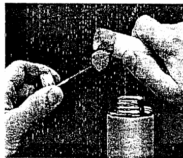
4 - Appliquer le solvant-ciment* sans excès (en couche mince) sur toute la longueur de l'embout mâle (repère du tube)
