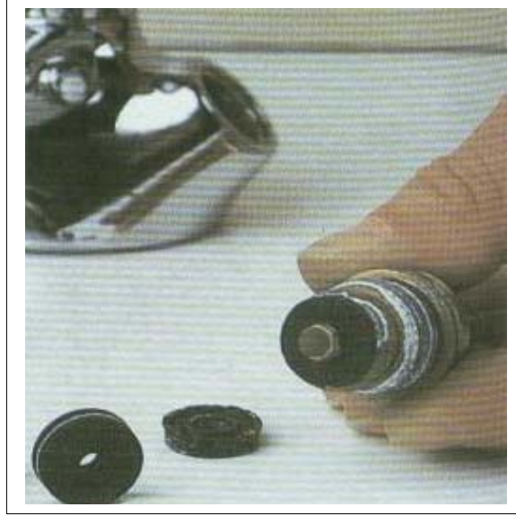
4.Changer le clapet par un neuf identique.
