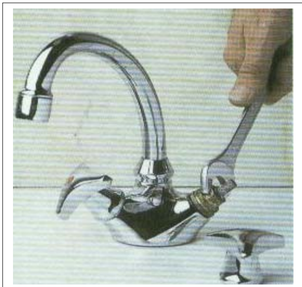
2. Retirer la poignée et dévisser la tête du robinet
