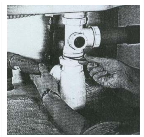
4. Remonter le siphon en vérifiant la position du joint.
